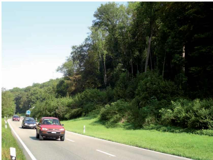
Abb 3 Zu Gunsten der Verkehrssicherheit zurückgesetzter Waldrand entlang einer Kantonsstrasse.
